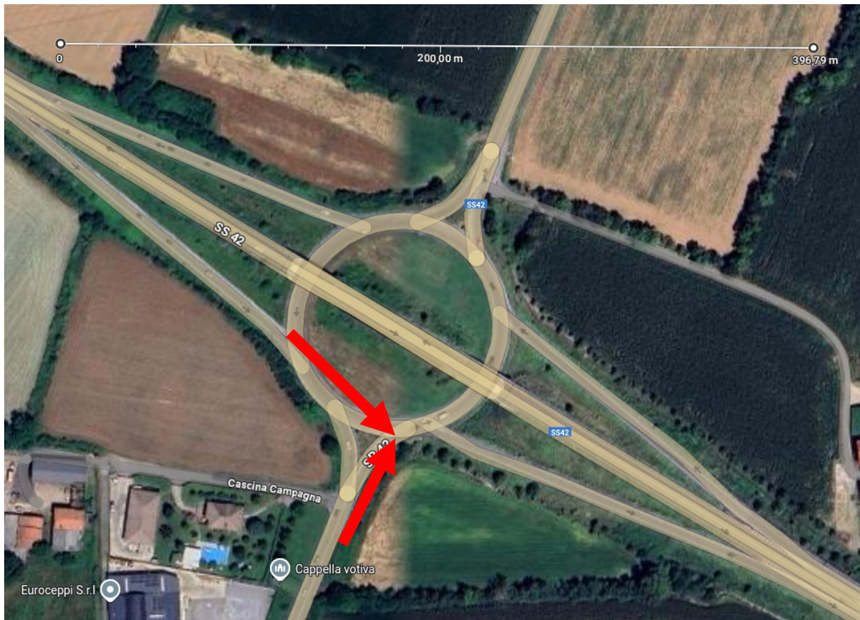
Tangenziale Sud, zona Stezzano con conflitto
